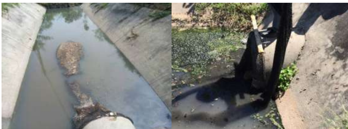
ภาพที่ 3.11 การติดตั้งตาข่ายที่ปากท่อระบายน้ำเพื่อดักขยะ เทศบาลนครระยอง
