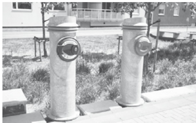
3 ท่อดูดขยะสาธารณะ ที่ติดตั้งบริเวณส่วนกลาง เพื่อนำมาทิ้งสะดวก
