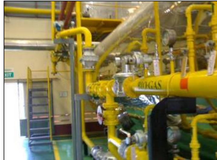
หลังปรับปรุงทำเข้า Boiler
