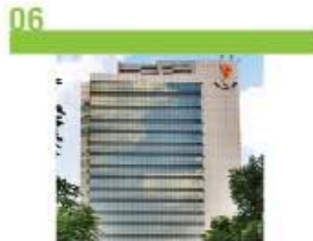
06 อาคารสำนักงานกลาง กฟผ. ก.102 การไฟฟ้าฝ่ายผลิตแห่งประเทศไทย
