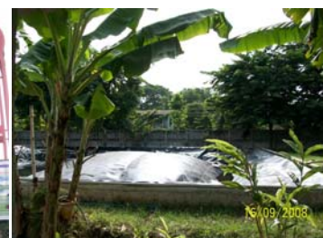
ถังหมักของเสียจากโรงฆ่าสัตว์ให้เป็นก๊าซชีวภาพ
