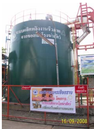
ถังหมักของเสียจากโรงฆ่าสัตว์ให้เป็นก๊าซชีวภาพ
