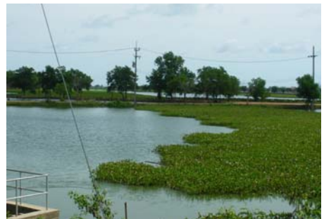
ระบบบำบัดน้ำเสียของเทศบาลนครหาดใหญ่
