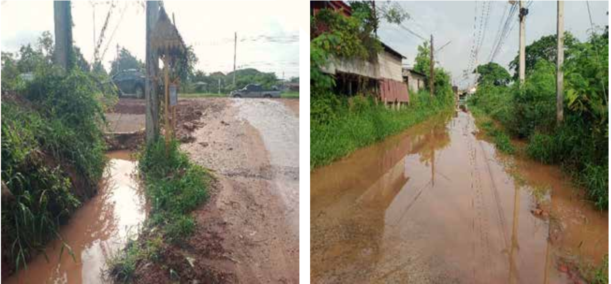
ภาพที่ 11 ภาพชุมชนเมืองในเขตพื้นที่เมืองหนองสำโรงที่อยู่ต่ำกว่าระดับถนนเส้นหลัก จึงเป็นแหล่งรับน้ำและทำให้เกิดน้ำท่วมซ้ำซาก
