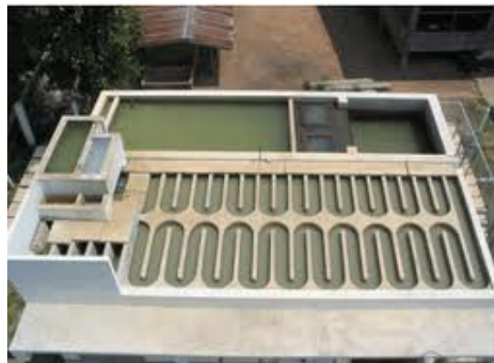
รูปที่ 4-4 ระบบบำบัดน้ำ 8
