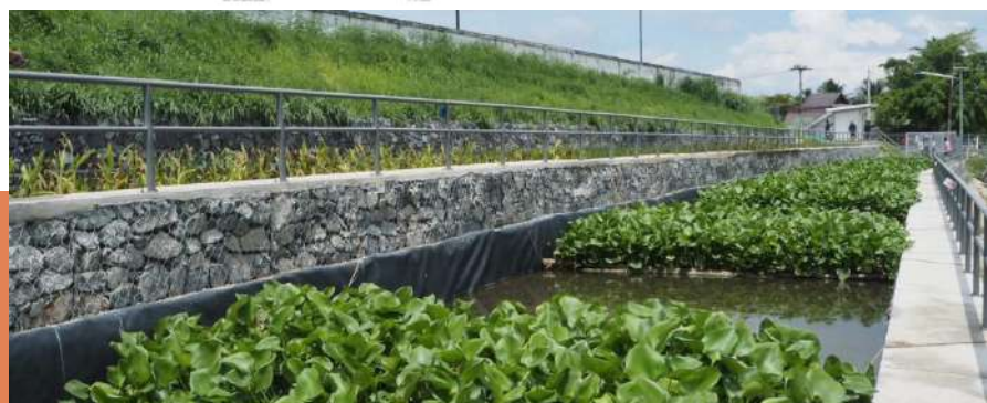
ตัวอย่างการทำบึงประดิษฐ์เพื่อบำบัดน้ำเสียโรงเรียนวัดบางบึง จังหวัดสมุทรสาคร ที่มา: โครงการสมุทรสาครสีเขียว โดยมูลนิธิบูรณะนิเวศ 2564
