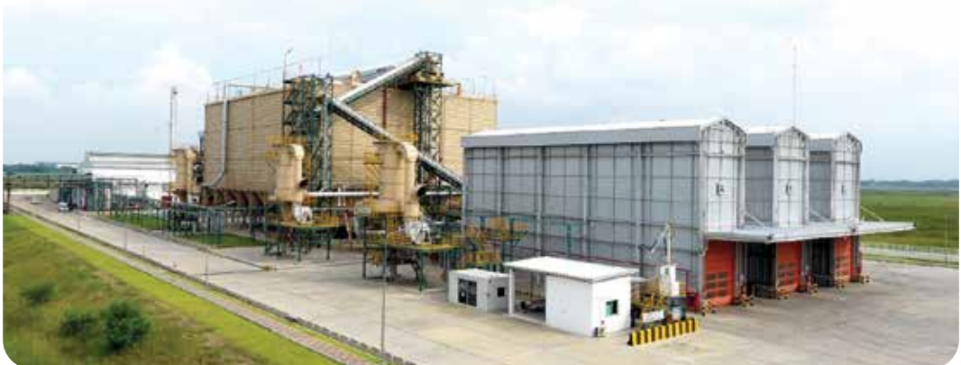
เทคโนโลยีหม้อต้มไอน้ำพลังงานชีวมวล เพื่อผลิตพลังงานเชื้อเพลิงใช้ในโรงงาน (ทดแทนการใช้น้ำมันเตา)
