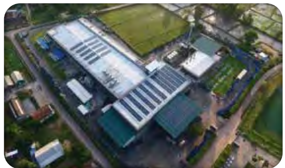
ภาพที่ 1 โซลาร์เซลล์ (Sollar Cell) นำใช้ในอาคารผลิตโรงงานหลวงฯ ที่ 3 (ต่างอย) จังหวัดสกลนคร
