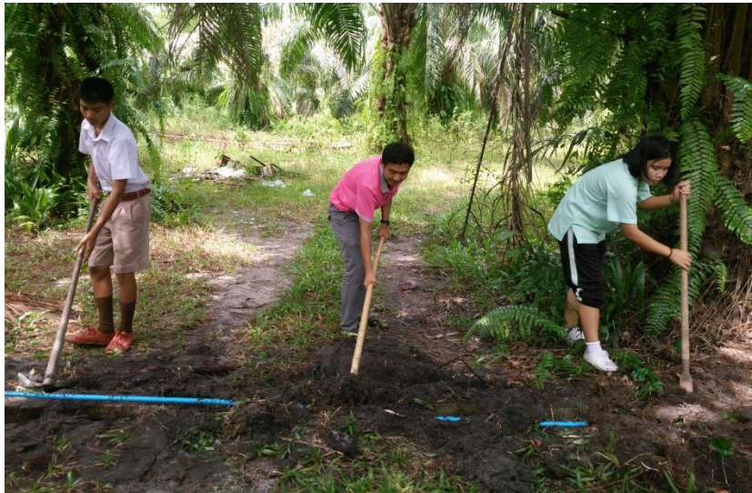
ภาพที่ 3.9 การวางท่อวางท่อน้ำใหม่เพื่อสะดวกในการเปลี่ยนน้ำ
