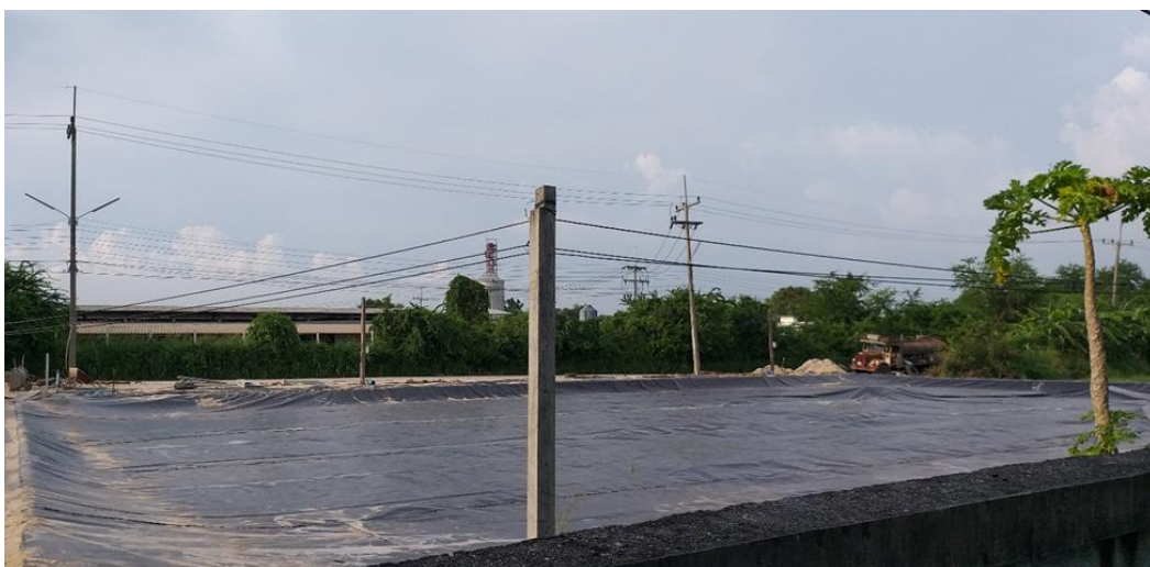
ภาพที่ 3.2 บ่อหมักก๊าซชีวภาพของ นาย สะอาด แซ่เฮงระหว่างปรับปรุงโดยการปูผ้าใบเก็บก๊าซใหม่
