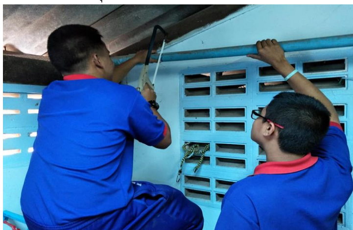
ภาพที่ 3.26 การปรับปรุงระบบก๊าซชีวภาพ 1
