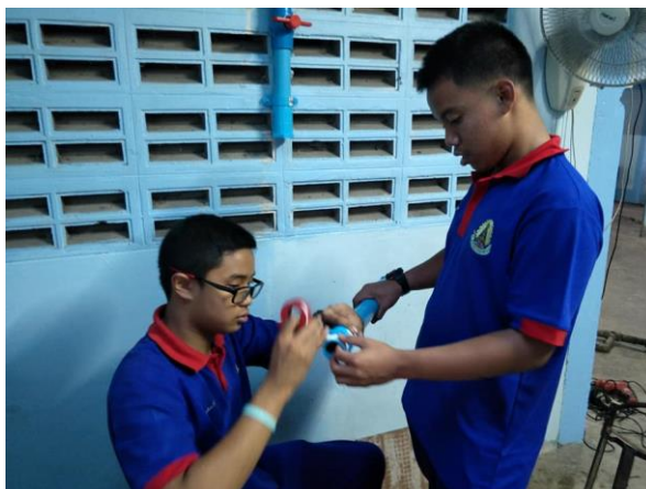
ภาพที่ 3.29 การปรับปรุงระบบก๊าซชีวภาพ 4
