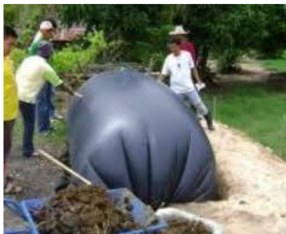
ภาพที่ 2.13 บ่อหมักก๊าซชีวภาพแบบถุง PVC
