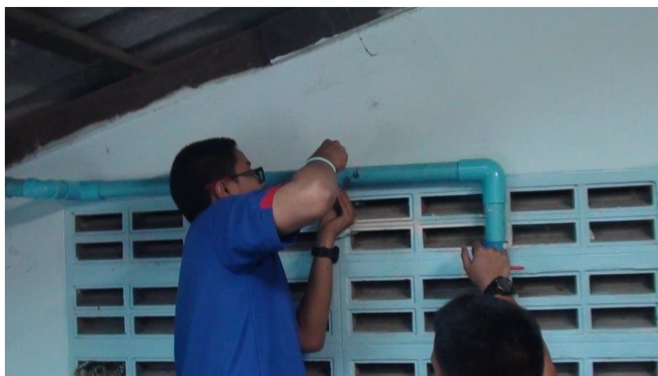
ภาพที่ 3.28 การปรับปรุงระบบก๊าซชีวภาพ 3
