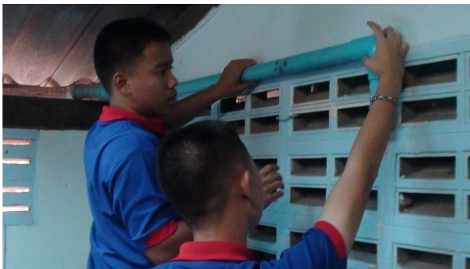
ภาพที่ 3.27 การปรับปรุงระบบก๊าซชีวภาพ 2
