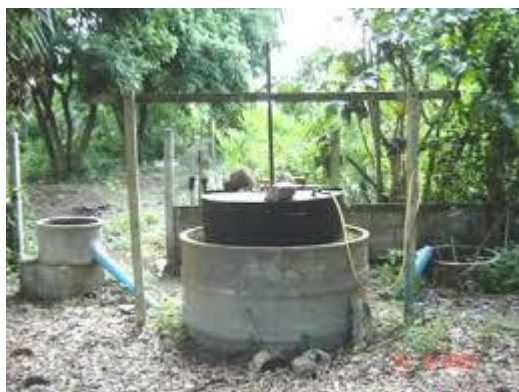
ภาพที่ 2.5 Floating drum digester
