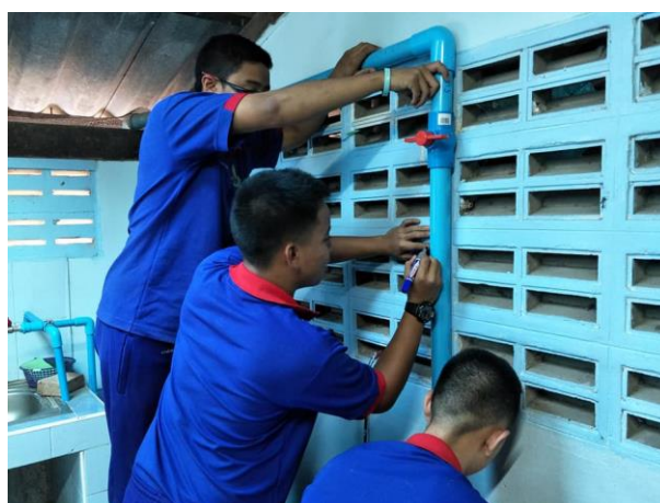
ภาพที่ 3.30 การปรับปรุงระบบก๊าซชีวภาพ 5
