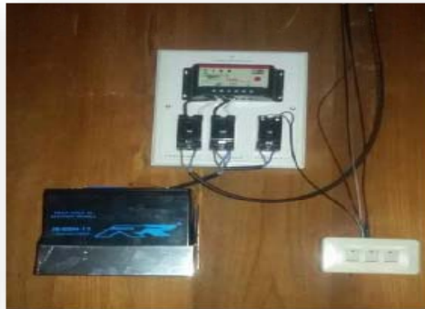
การติดตั้งระบบควบคุม
