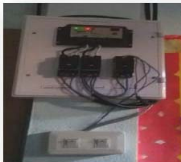
การติดตั้งระบบควบคุม
