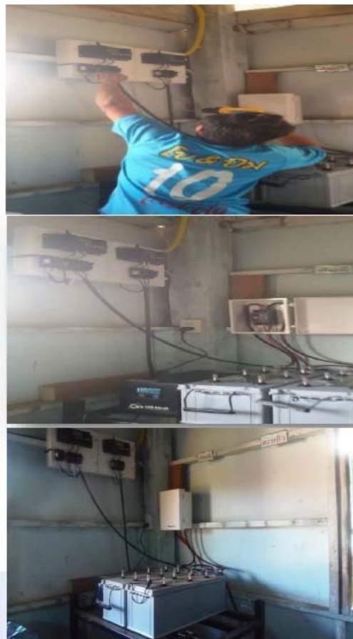
การติดตั้งระบบควบคุม
