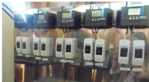
การติดตั้งระบบควบคุม
