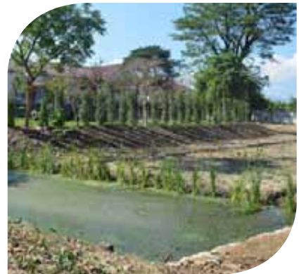
การปรับปรุงระบบบำบัดน้ำเสียภายใน โรงฆ่าสัตว์ของทางเทศบาลนครเชียงราย
